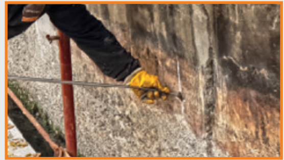
Mise en place du micro-ancrage
