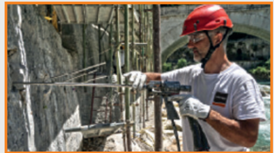
Injection de la résine expansive
