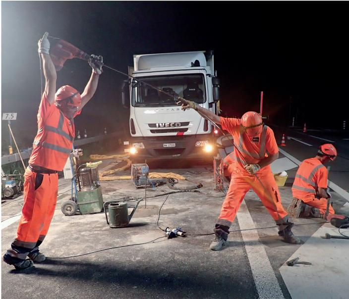
Mise en place de la lance d'injection jusqu'à -8 m
