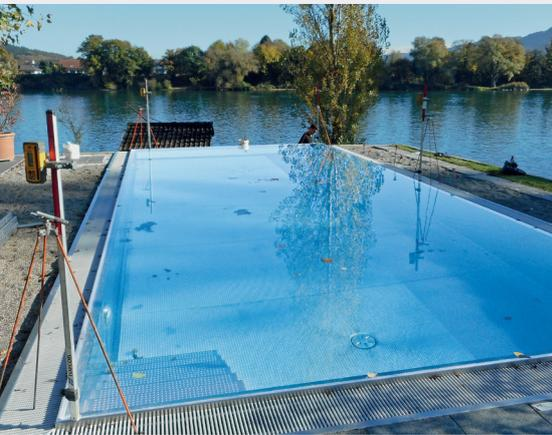
La piscine indépendante, qui se trouve à 6 m environ du Rhin, a été construite en 2011; il s'agit d'une construction en acier-chromé avec une surverse. Le bassin est placé sur une dalle de fondation armée
