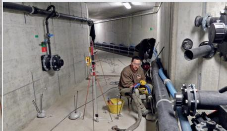
largeur, 3.80 m de hauteur et de 10 m de longueur) qui reposent sur des dalles d'env. 0.45 m d'épaisseur. Elle est recouverte d'env. 15 cm de scories. Pour l'exécution de ce projet, tout l'équipement de travail de URETEK a été chargé sur un petit véhicule pour être amené à l'endroit des injections dans la galerie ayant subi un basculement et le sous-sol sous les deux éléments de raccordement ont été stabilisés au cours de 3 journées ouvrables.
