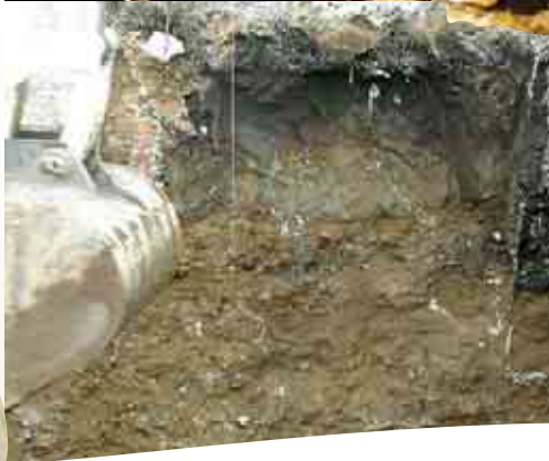
Campione di terreno limoso-argilloso trattato con resina Geoplus®.
