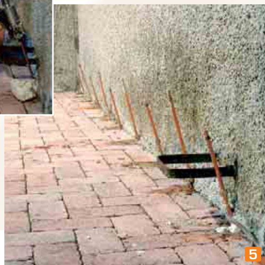
FINE LAVORI: I TUBI DI RAME VENGONO POI TAGLIATI A LIVELLO DELLA PAVIMENTAZIONE.
