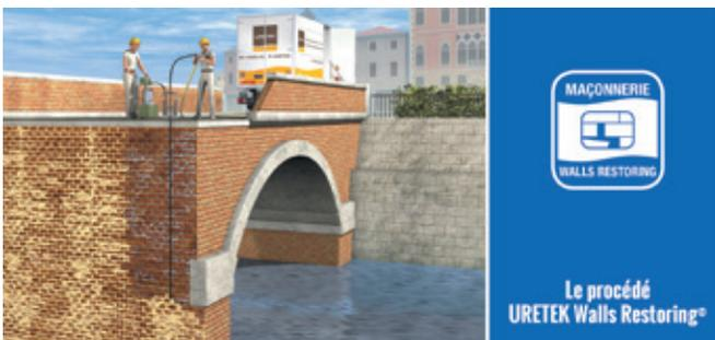
Le procédé **URETEK Walls Restoring®** permet de restaurer le mortier de différentes maçonneries.
