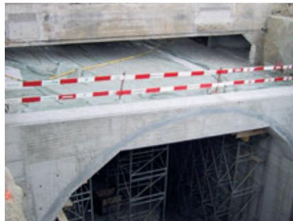
l'intérieur de la culée de pont. La fouille est longue d'env. 90 m, large d'env. 12 m et présente une profondeur allant jusqu'à 13 m. Il a fallu améliorer le terrain directement sous la culée et le sécuriser pour l'excavation.
