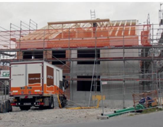
Die Überbauung bestehend aus 3 Gebäuden ist im gemeinsamen Untergeschoss/der Einstellhalle aus einer armierten Beton-Konstruktion. Die Fundation besteht aus einer 25 cm starken Fundamentplatte,
