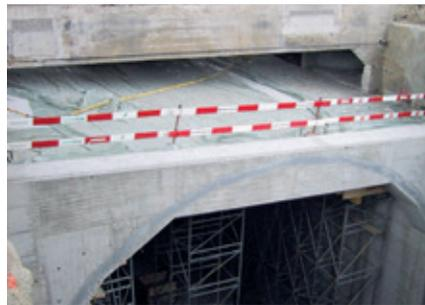
des Brückenlagers erstellt. Die Baugrube hat eine Dimension von ca. 90 m Länge, ca. 12 m Breite und variable Tiefen bis ca. 13 m. Unmittelbar unterhalb des Brückenlagers musste der Baugrund verbessert und für den Aushub gesichert werden.
