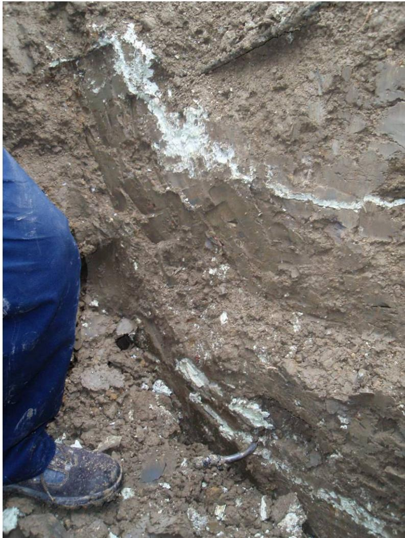
*Figura 14, espansione del materiale di iniezione nel tegel*
