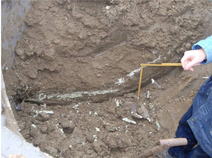
*Figura 13, espansione del materiale di iniezione nel tegel*
