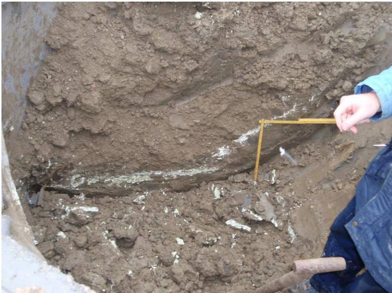
*Figure 13, expansion du matériel d'injection dan le Tegel*
