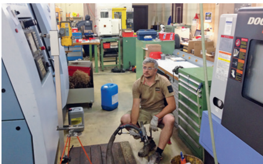
Injection de la résine dans la cavité comblée préalablement avec l'argile expansée Liapor
