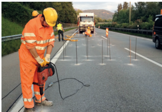
Perçages (diamètre 12 mm) et des lances d'injection posées
