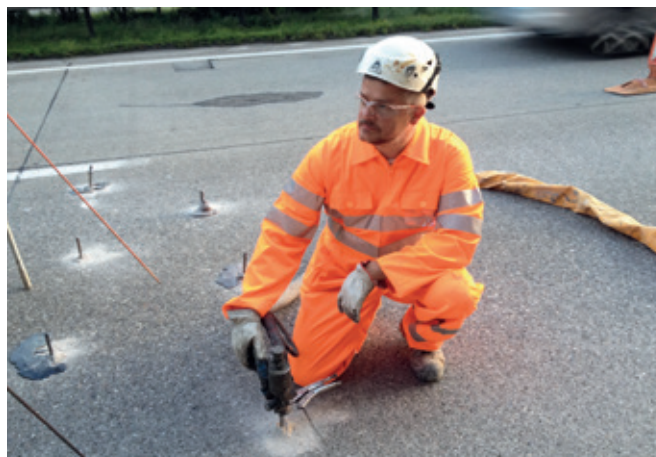
Injection de la résine
