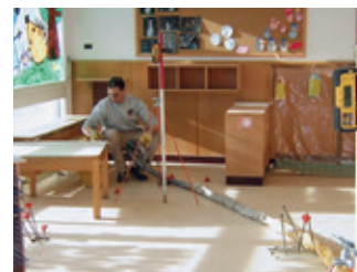
Injectons de résine (une fois le matériau de comblement soufflé et les lances posées)
