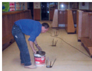
Fermeture de l'ouverture de soufflage
