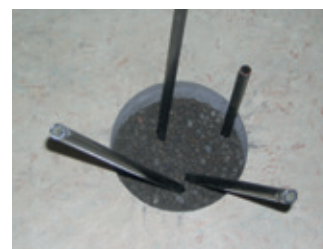
Ouverture de soufflage (cavité avec matériau de comblement soufflé et lances d'injection)
