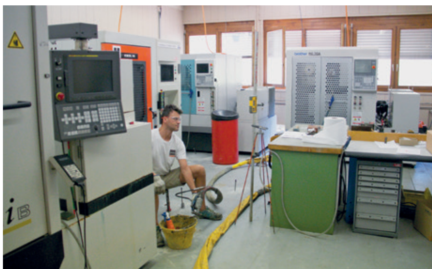
Images: travaux d'injection avec relevage du sol de la halle (jusqu'à 22 cm)
