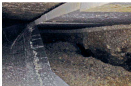
Cavités de jusqu'à 40 cm de profondeur
