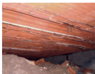
Cavité avant le traitement avec URETEK Cavity Filling®
