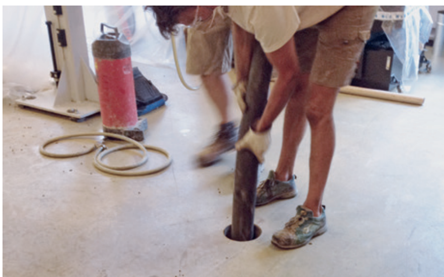
Soufflage d'argile expansée Liapor
