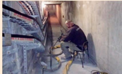
ca. 6 cm gesetzt. Der Verbindungsgang besteht aus einer armierten Betonkonstruktion, welche aussen auf der Seite zum Gletscher mit Steinplatten verkleidet und auf der anderen Seite mit Erd-Material hinterfüllt ist. Der Untergrund besteht aus einer Aufschüttung aus Steinen mit viel Erdmaterial. Nachdem die gesamte Arbeitsinstallation aus dem Service-LKW ausgebaut, mit Luftseilbahn und Helikopter zur Berg-Station transportiert wurde, konnte der Verbindungsgang stabilisiert werden.
