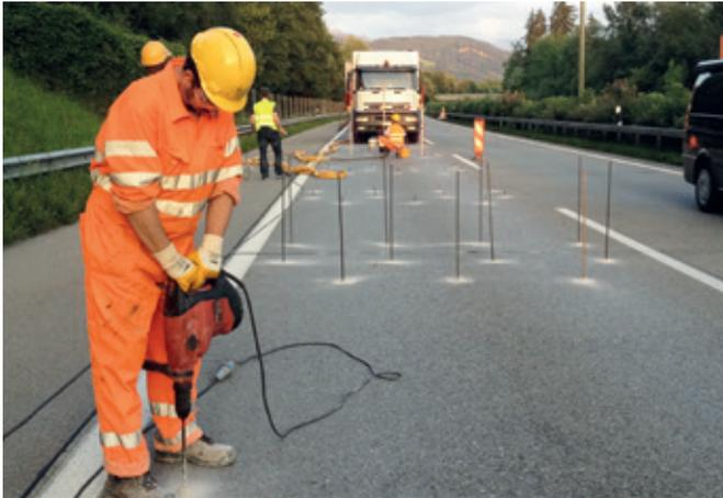
Bohrungen (Durchmesser 12 mm) und gesetzte Injektionslanzen
