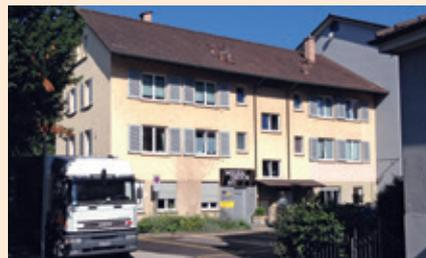
(in Holz-Leichtbauweise) aufgestockt werden. Da die Fundation nur für die bestehenden Lasten dimensioniert war, wurde eine Verstärkung des Fundamentuntergrundes erforderlich, um die neuen, zusätzlichen Lasten zu tragen. Das MFH hat eine Fläche von ca. 185 m<sup>2</sup>, und die ca. 50 cm breiten und ca. 50 cm tiefen Streifenfundamente wurden in verschiedenen Bereichen mit höheren Lastabtragungen bis in eine Tiefe von ca. -2 m ab UK Fundament auf einer Gesamt-Länge von 28 m stabilisiert.
