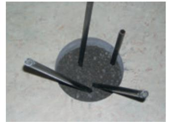
Einblase-Öffnung (Hohlraum mit eingeblasenem Füll-Material und Injektionslanzen)
