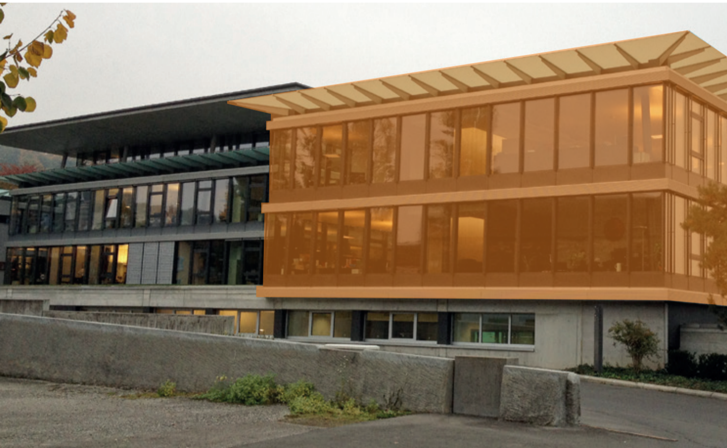
Aufstockung beim Centre Patronal, Paudex – URETEK erhöhte die Tragfähigkeit des Fundamentuntergrundes
