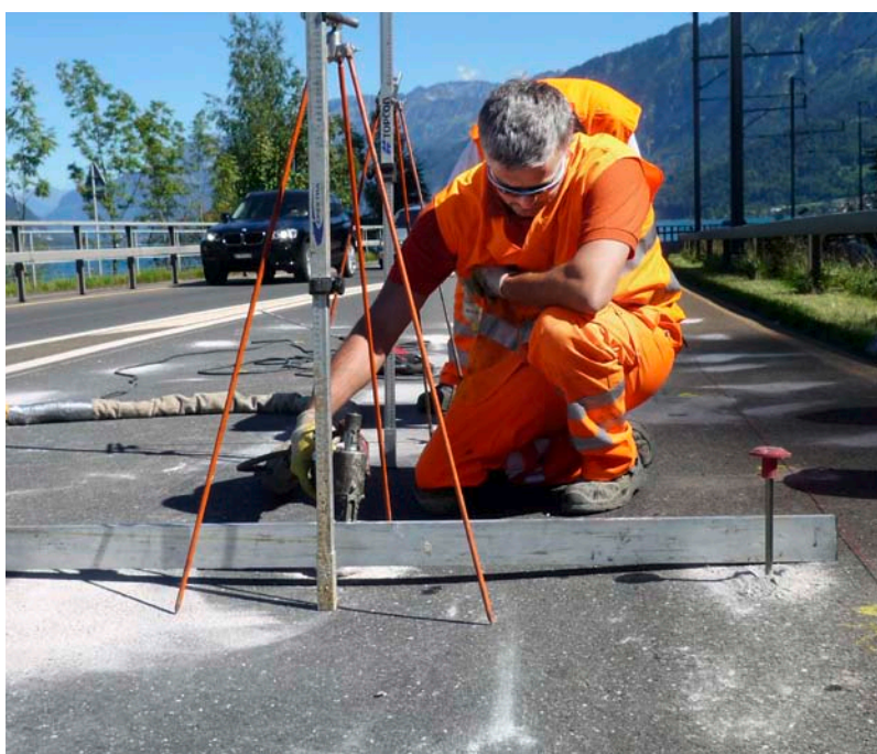
Kunstharzinjektionen in verschiedenen Tiefen. (Bild: Uretek)
