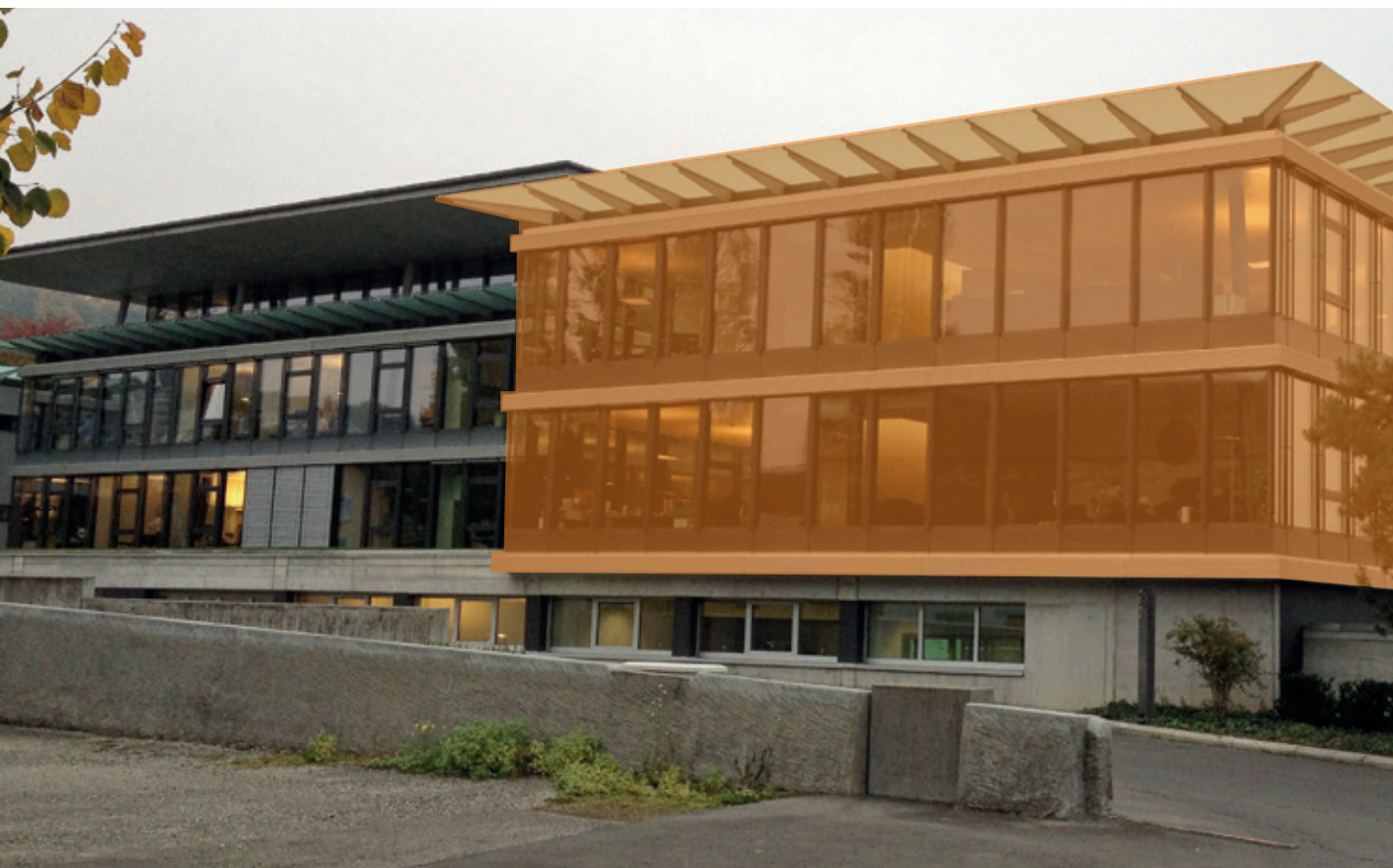
Construction d'un étage au Centre Patronal, Paudex – URETEK a augmenté la portance du sol sous les fondations
