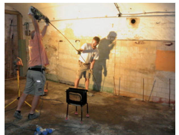
Forage pour les lances d'injection
