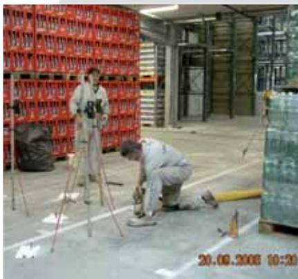
En 2006, Coca-Cola érigeait un nouvel entrepôt. Les vibrations provoquées par le passage des chariots élévateurs engendrèrent la formation de cavités sous les dalles de béton, au niveau des jointoiments. De plus, des fissures se développèrent dans le sol autour des joints. Pour éviter l'amplification des dommages dus aux charges dynamiques provoquées par le déplacement des chariots élévateurs, le sous-sol se trouvant sous les dalles de béton, dans la zone des jointoiments
