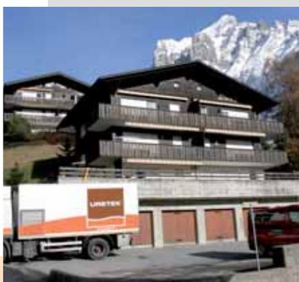
Cet immeuble d'appartements de trois étages comprend six unités d'habitation, et a été érigé en 1973. Il se trouve dans une zone dite de mouvements différentiels. L'immeuble repose sur un radier, et du côté de la vallée sur un garage en béton armé placé en amont.
