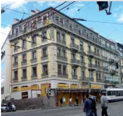
Cet immeuble commercial de six étages repose sur des semelles filantes en béton. Les travaux d'excavation et de construction de l'immeuble voisin menèrent à une désagrégation du sous-sol et à des tassements importants. Des travaux de transformation de l'immeuble Georges-Favon engendrèrent des tassements supplémentaires, car l'ajout de nouvelles dalles de béton provoqua une augmentation de la charge d'env. 5-10%. Les tassements furent aussi causés par la diversité des matériaux
