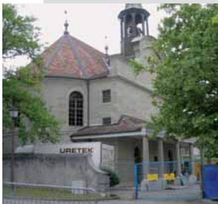
Les périodes sèches et la déshydratation causée par les arbres provoquèrent des tassements et la formation de fissures dans l'église. Des sondages des fondations démontrèrent que la maçonnerie de fondation commençait elle aussi à s'affaïsser.
