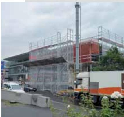
Le siège de l'organisation économique est composé de plusieurs complexes immobiliers de quatre ou d'un étage(s). Sous ce dernier se trouve un vaste garage souterrain. Deux étages supplémentaires furent ajoutés à un complexe d'immeubles d'un étage. L'augmentation de charge résultante nécessita un accroissement de la portance du sol de fondation dans le secteur du rehaussement. L'augmentation de portance requise fut calculée à l'aide d'essais au pénétromètre, puis
