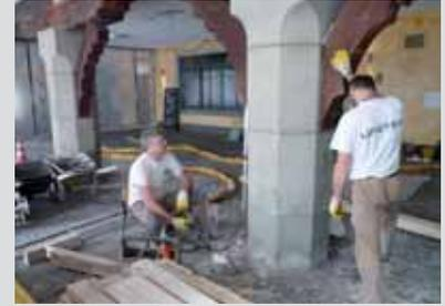
Deux variantes de stabilisation furent discutées : d'une part l'enfoncement de micropieux, et d'autre part le renforcement du sol se trouvant sous les fondations. Préalables : les piliers en pierre naturelle âgés de plus de 500 ans ne devaient pas être altérés. Et comme le sol de la fondation se trouvait à plus de 2,0 m en dessous de la surface du terrain, le transfert des forces sur les micropieux aurait nécessité des efforts importants (par ex. insertion de poutrelles en acier).
