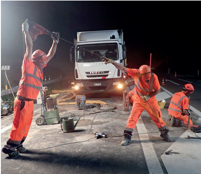
Abteufen der Injektionslanze bis -8 m
