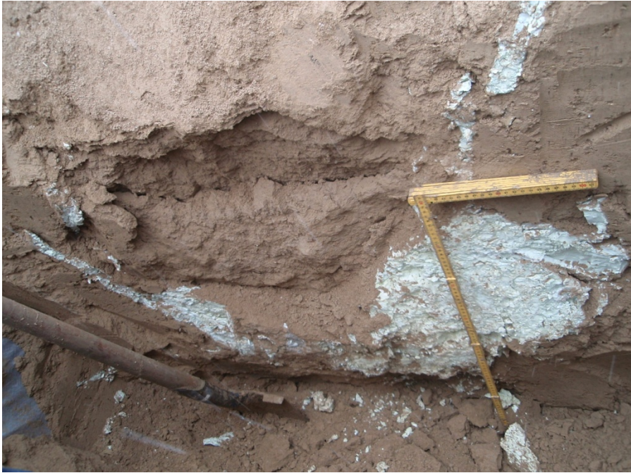
Abbildung 18, Ausbreitung des Injektionsgutes im Bereich der Injektionsstelle
