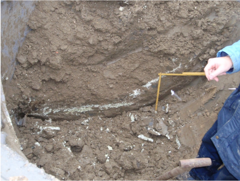
Abbildung 13, Ausbreitung des Injektionsgutes im Tegel
