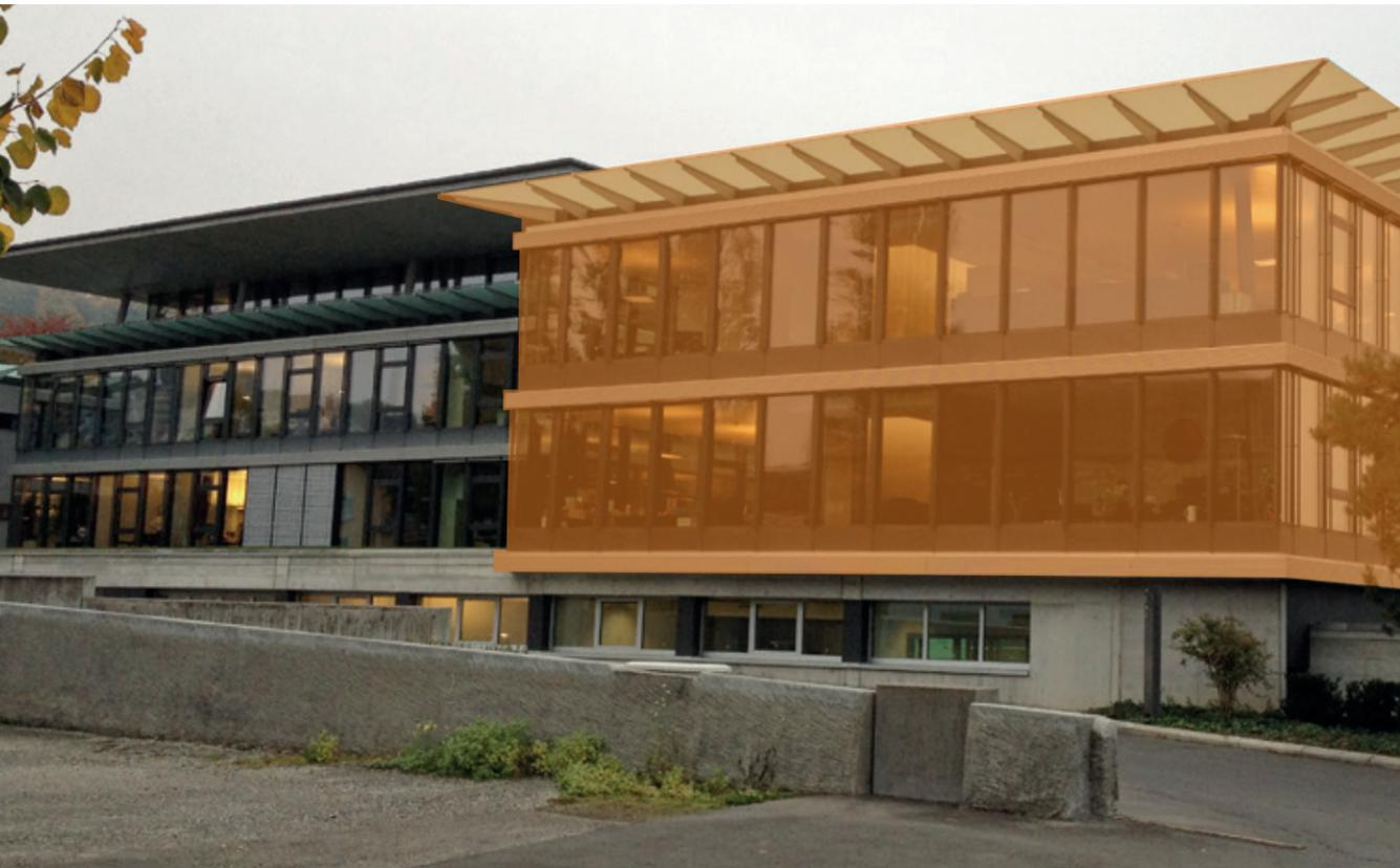
Construction d'un étage au Centre Patronal, Paudex – URETEK a augmenté la portance du sol sous les fondations
