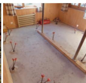
permis de trouver une couche de sol plus stable qu'à -1.80 m du bord supérieur du sol du rez-de-chaussée. Malgré l'absence d'une dalle de fondation, le bâtiment a pu être relevé grâce aux injections réalisées en dessous de cette couche compacte; ceci a permis un relevage réparti de manière homogène sur toute la surface.
