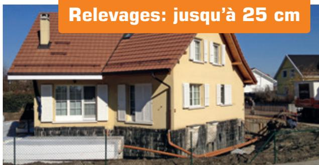
Le lotissement «En Pontou» se situe dans une zone en partie très sensible au tassement (sol à teneur en craie lucustre et de matériaux organiques, à forte teneur en eau). En raison d'un remblai supplémentaire d'environ 2 m après construction des maisons, on a pu observer des tassements et des inclinaisons des 6 maisons individuelles.
