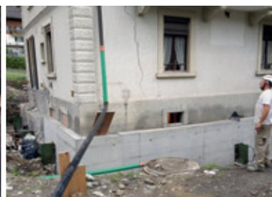
En raison des dimensions du bâtiment, 7 vérins hydrauliques ont été positionnés à différents endroits des nouveaux murs de béton/de la nouvelle dalle de fondation afin de soutenir le processus de levage pendant les injections. Malgré des conditions particulièrement difficiles, la maison a pu être remise dans sa position initiale grâce à un relevage d'environ 20 cm.
