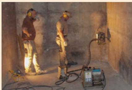
du parking souterrain se composent de semelles filantes et d'une dalle de fondation d'environ 20 cm avec des joints de dilatation. En raison du sol fortement limoneux et sableux des tassements et des fissures jusqu'à 10 cm sont apparus avec le temps suite à l'assèchement et aux lessivages du sol et aux variations du niveau de la nappe phréatique. Les travaux ont duré 9.5 jours et les injections ont concerné 87 ml de semelles filantes et 108 m<sup>2</sup> de dalle de fondation.
