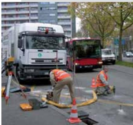
Die stete Belastung durch den Busbetrieb führte zu Stufenbildungen zwischen den einzelnen Betonplatten von bis zu 4 cm. Zusätzlich führte Eindringen von Regenwasser zum «Pumping-Effekt».
