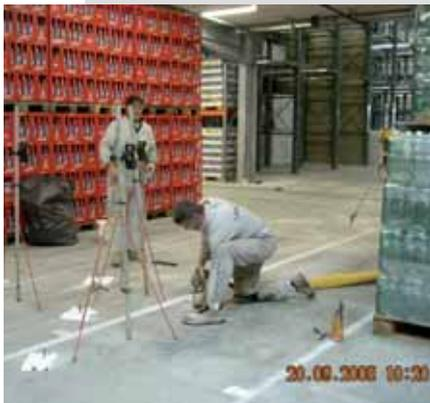
2006 erstellte Coca-Cola eine neue Lagerhalle. Die beim Darüberfahren der Stapler erzeugten Schwingungen führten zur Bildung von Hohlräumen unterhalb der Betonplatten im Fugenbereich. Entlang der Fuge bildeten sich zudem Risse im Boden. Um grössere Schäden durch die dynamischen Belastungen durch Staplerfahrten zu vermeiden, wurde der Untergrund unterhalb der Betonplatten im Fugenbereich (47 ml) verfüllt und stabilisiert. Während den Ausführungen wurden regelmässig
