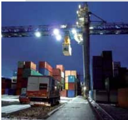
Beim Container-Umschlagplatz Frenkendorf führten Ausschwemmungen von Feinmaterial (Pumping Effekt) zur Bildung von Hohlräumen im Fundamentuntergrund. Die davon betroffenen beiden Bereiche der Kran-Bahn, 15 ml und 20 ml, setzten sich um ca. 2 cm und 3 cm. Bei der Durchfahrt des Krans lief das Fahrwerk auf der Schiene auf. Mittels der Methode Deep Injections® wurden von Uretek Schweiz AG Hohlräume unter dem Fundament erfolgreich verfüllt und der Untergrund verpresst.
