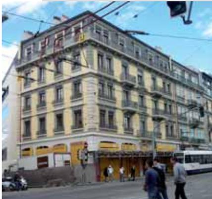
Das 6-stöckige Geschäftshaus ist auf Beton-Streifenfundamenten fundiert. Aushub und Bau des Nachbargebäudes führten zu einer Auflockerung des Untergrundes und zu grösseren Setzungen. Umbauarbeiten des Gebäudes Georges Favon lösten weitere Setzungen aus, denn durch das Einbringen von neuen Betondecken wurden die Lasten um ca. 5–10% erhöht. Ein weiterer Grund für die Setzungen ist im unterschiedlichen Untergrund zu finden (im Setzungsbe reich liegt Schüttmaterial). Mit Deep In-
