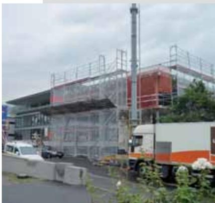
Der Sitz der Wirtschaftsorganisation besteht aus mehreren 4- sowie aus 1-stöckigen Gebäudekomplexen. Darunter liegt eine gross angelegte Tiefgarage. Ein einstöckiger Gebäudekomplex wurde um zwei weitere Stockwerke aufgestockt. Die daraus resultierende Lasterhöhung erforderte eine Erhöhung der Tragfähigkeit des Fundamentuntergrundes im Bereich der Aufstockung. Die erforderliche Erhöhung der Tragfähigkeit wurde durch Rammsondierungen ermittelt und kontrolliert. Uretex führte
