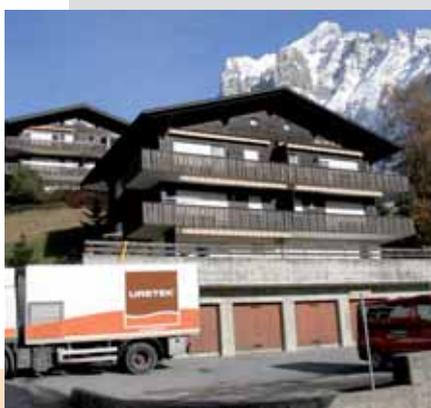
Das 3-stöckige Appartementhaus besteht aus 6 Wohneinheiten und entstand 1973. Es steht in einer Zone sogenannter differenzieller Bewegungen. Das Gebäude liegt auf einer Fundamentplatte, talseitig auf einer armierten, vorgelagerten Betongarage auf.
