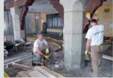
Zur Stabilisierung standen zwei Varianten zur Diskussion: Einerseits das Abteufen von Mikropfählen und andererseits das Verfestigen des Baugrundes unter den Fundamenten. Vorgabe: Die mehr als 500-jährigen Natursteinsäulen durften nicht verändert werden. Und da die Fundamentsohlen mehr als 2.0 m unter der Terrainoberfläche liegen, würde die Krafteinleitung in die Mikropfähle sehr aufwändig (z. B. Unterziehen von Stahlträgern).
