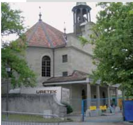
Trockenperioden und Wasserentzug durch Bäume führten zu Setzungen und Rissbildung bei der Kirche. Sondagen bei den Fundamenten zeigten auf, dass auch das Fundamentmauerwerk begann in sich zusammen zu fallen.
